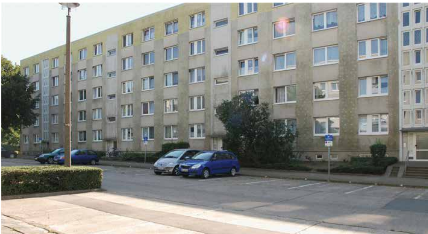
Prof.-Frege-Straße 62-68 vor der Modernisierung
